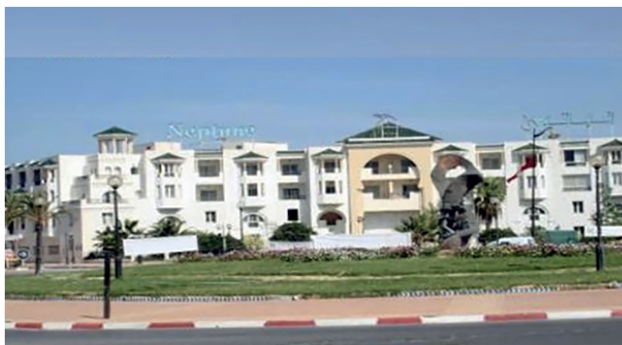
Situé à l'entrée de la station Hammamet Sud, le Neptune ne trouve toujours pas acquéreur et sombre dans l'abandon
