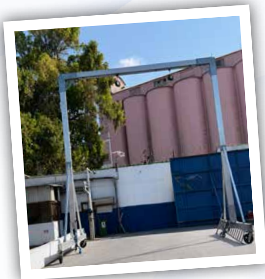
Ligne de vie mobile à SFBT BAB SAADOUN
