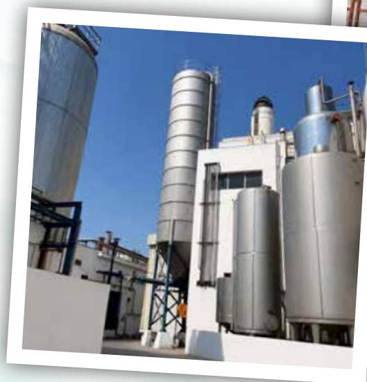
Silo de stockage de la drêche
